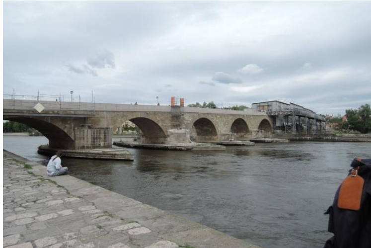
Abb. 6: Steinernen Donaubrücke. Bild: F. Schalamon
